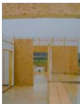
Montage panneaux de bois
