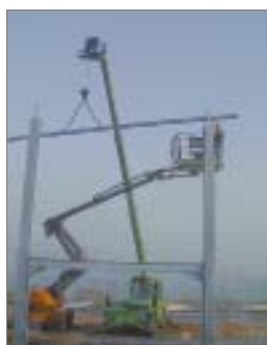
Montage structure métallique
