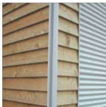
Détail angle bâtiment extérieur
