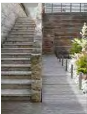
Au sol : platelage bois en ipé - Façades : bardage bois en red cedar
