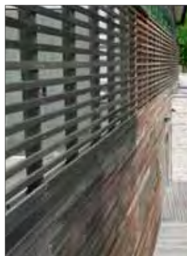
Au sol : platelage bois en ipé - Façades : bardage bois en red cedar
