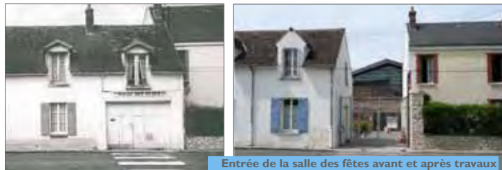
Entrée de la salle des fêtes avant et après travaux
