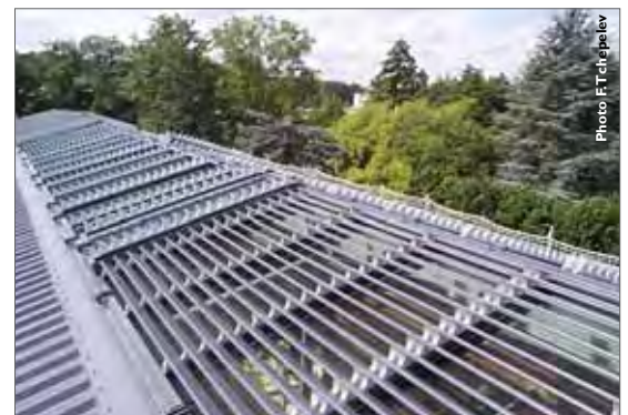
Verrière en toiture éclairant la salle sur toute sa longueur
