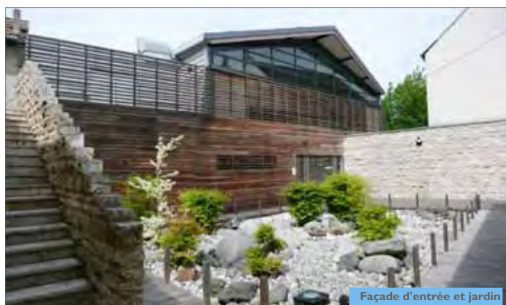
Façade d'entrée et jardin
