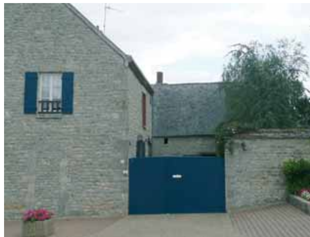
En milieu urbain ou rural, la clôture d'une parcelle sur rue est souvent composée d'un mur de façade, d'un mur de jardin ou de cour et d'un portail.
