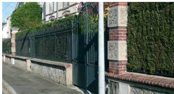
Unité parfaite car toutes les clôtures de cette rue chartraine sont identiques : murets et piliers en moellons et briques, grilles et portails métalliques verts, même hauteur des éléments.
