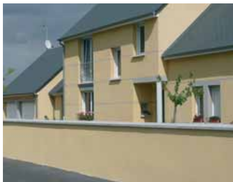
Synchronisme : le style, les matériaux et la couleur unifient cette maison et la clôture.
