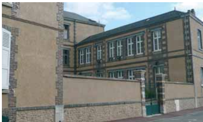
Le mur de clôture de cette résidence prolonge les façades, reprenant les mêmes matériaux dans la même typologie : soubassement en pierre, bandeaux en brique... et les mêmes finitions.
