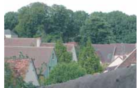
Unité de toitures en basse ville de Chartres. Où est la couverture neuve ?
